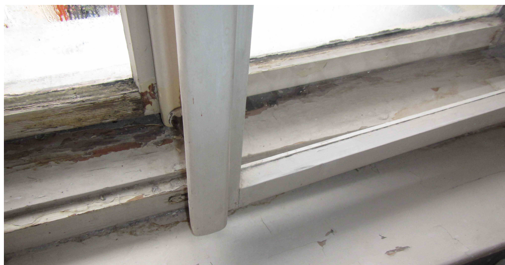
OKNO ŠPALETOVÉ – ŠPATNÝ STAV NEZDOBNÉ RÁMY KŘÍDEL
